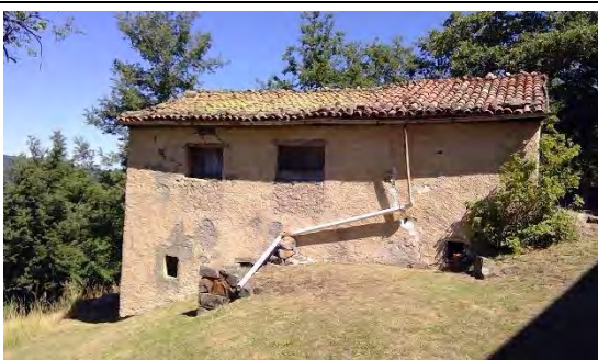
Località I Salti, vista laterale
