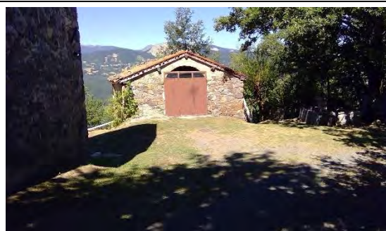
Località I Salti, vista frontale
